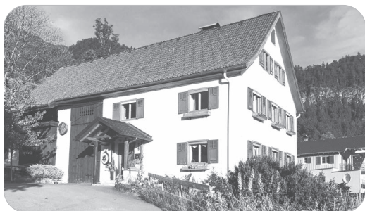
Das „Gmeiner Huus“ im Barx wurde zur Begegnungsstätte umgebaut.
